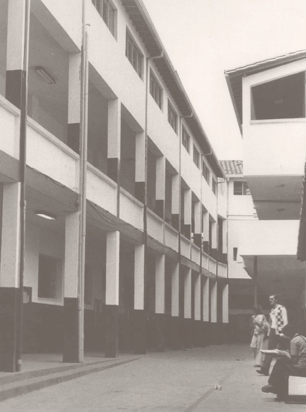
► Actual Corredor de las Palmeras. Archivo Institucional. 1976
