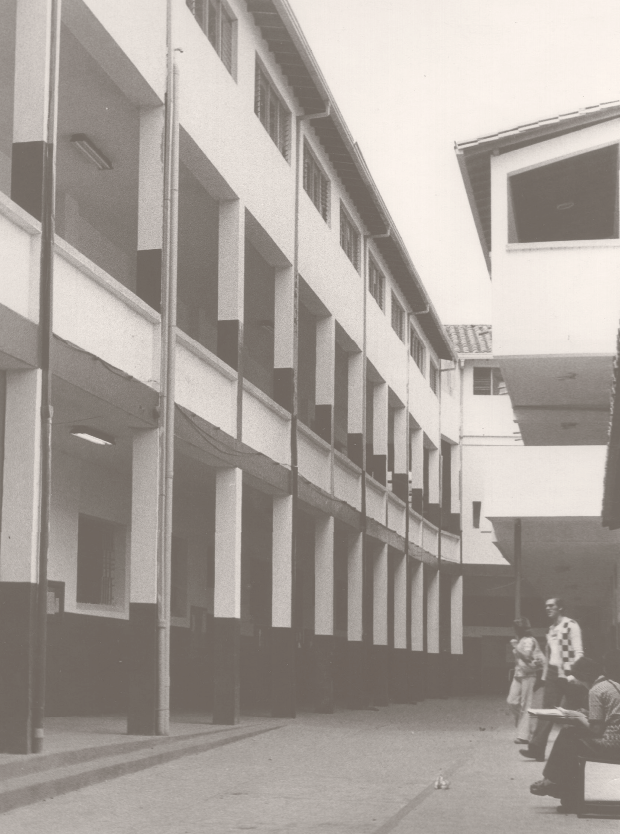
► Actual Corredor de las Palmeras. Archivo Institucional. 1976
