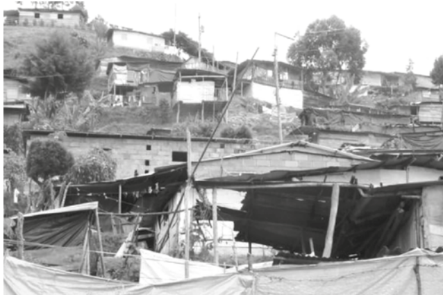
Figura 8.2. Panorámica del barrio
